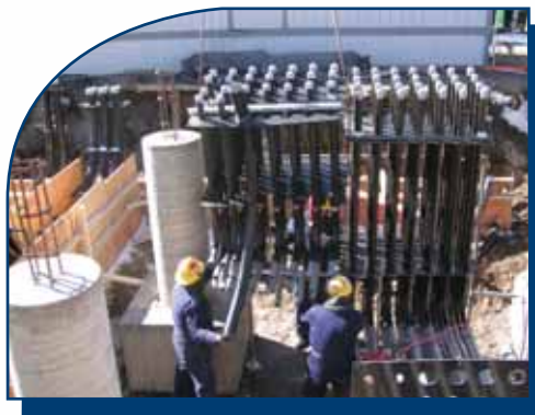
Crew installing prefab conduit
