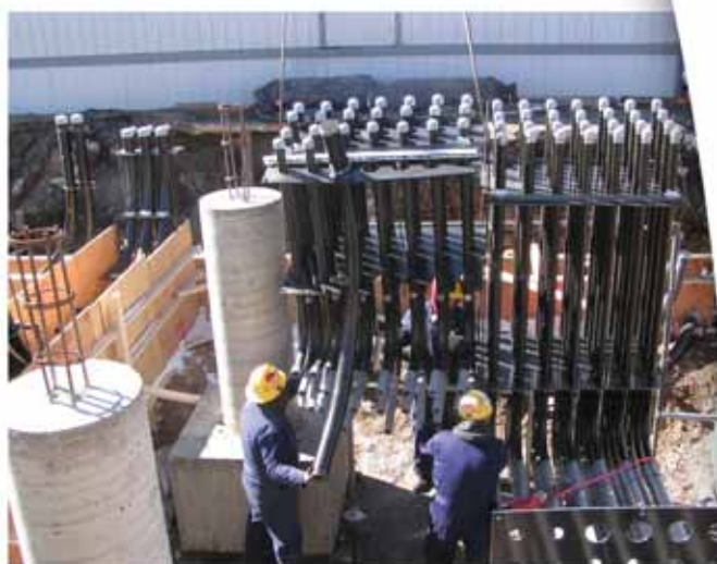
Crew installing prefab conduit
